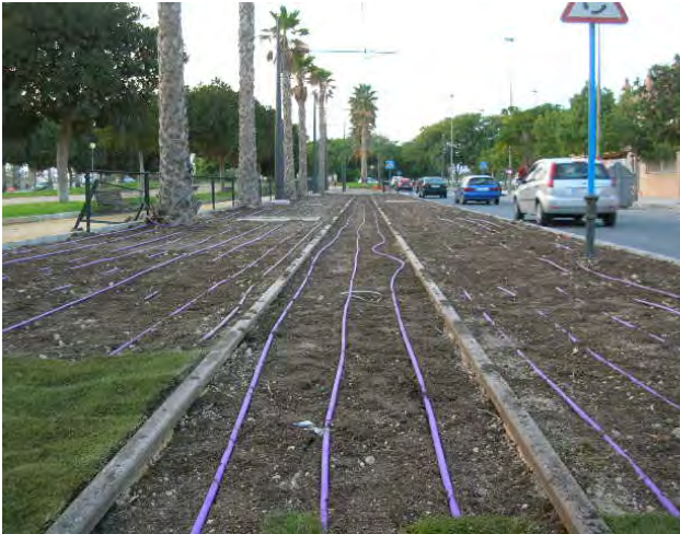
Tram de Alicante. Riego enterrado con Uniboline 17 mm (tubería integrada con las mismas características que Unitechline, pero especialmente diseñada para trabajar caguas regeneradas). Fecha de ejecución:2005-2006
