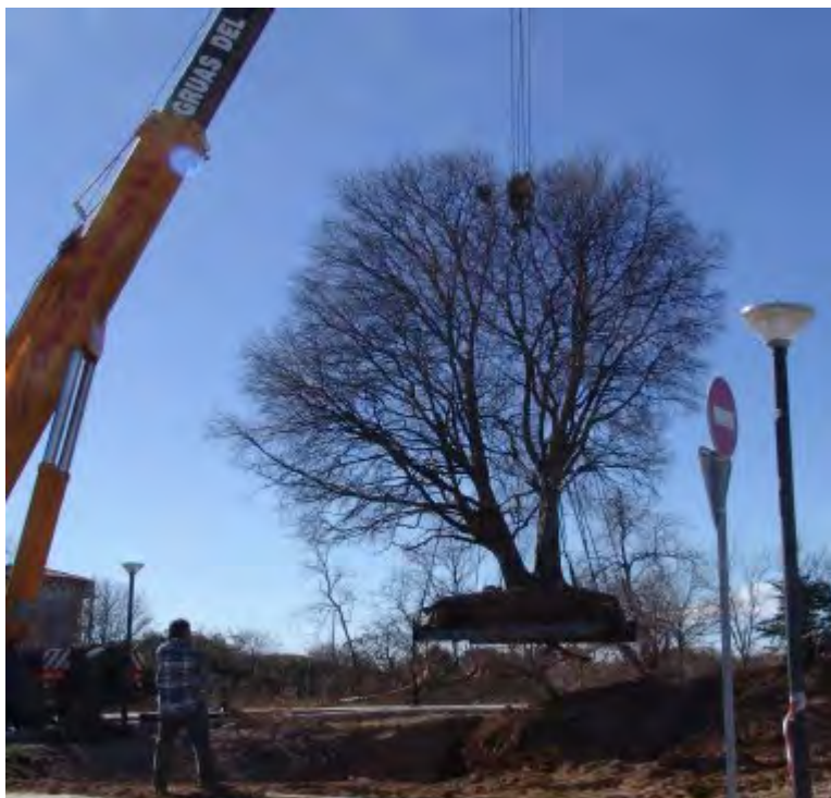
Momento del trasplante del almez de la primera fotografía, la altura del árbol es de unos 15 metros, la grúa usada fue de 250 TN.
