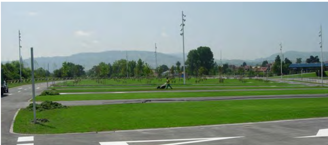
Aparcamiento permeable de césped reforzado en la Guía, Gijón.
