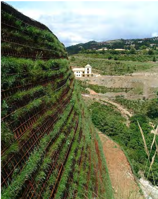
Talud de la urbanización La Zagaleta en Málaga. Tubería integrada Unitechline 17 mm. Fecha de ejecución: 2002
