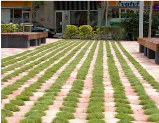
Platja d'Aro (Girona) Riego enterrado bajo el pavimento. Tubería Unitechline 17 mm Fecha de ejecución 2003
