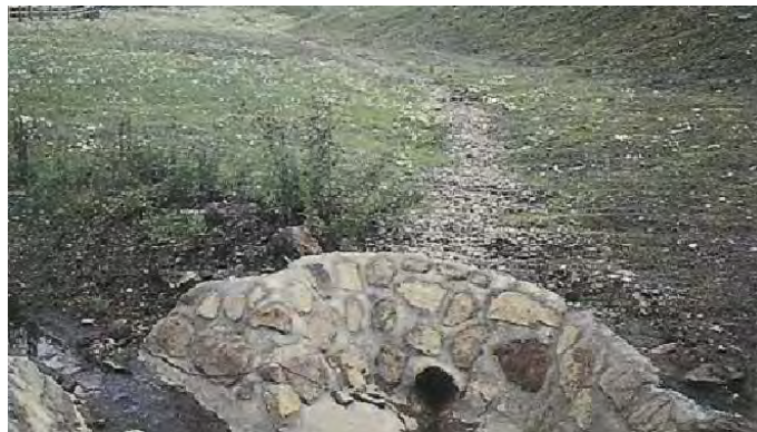
Zanja de infiltración
