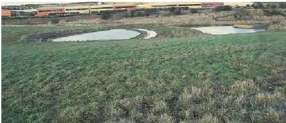
Franja filtrante terminando en un conjunto de estanque y humedal.
