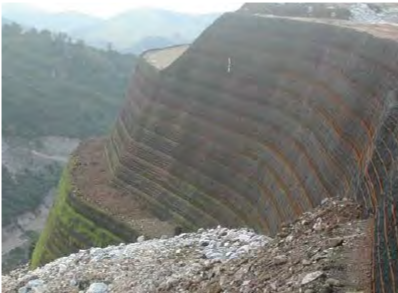
Talud de la urbanización La Zagaleta en Málaga. Tubería Unitechline 17 mm. Fecha de ejecución: 2002
