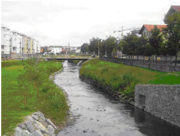
Obra de restauración del canal Artía-Irán. Gobierno Vasco. visitada durante el congreso
