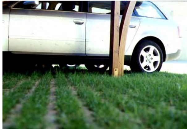
Riego enterrado bajo el pavimento en un aparcamiento. Tubería Unitechline 17 mm
