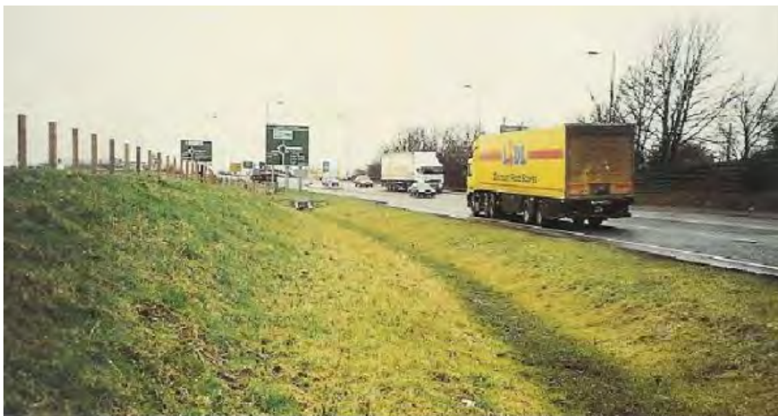
Cuneta verde en una carretera del Reino Unido.
