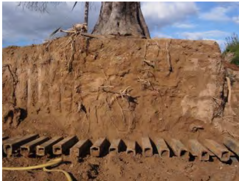
Detalle de la plataforma vista desde abajo durante el movimiento de un almez (peso 66 TN) (arriba), y de cómo se ve la plataforma antes de que el árbol sea movido (abajo)
